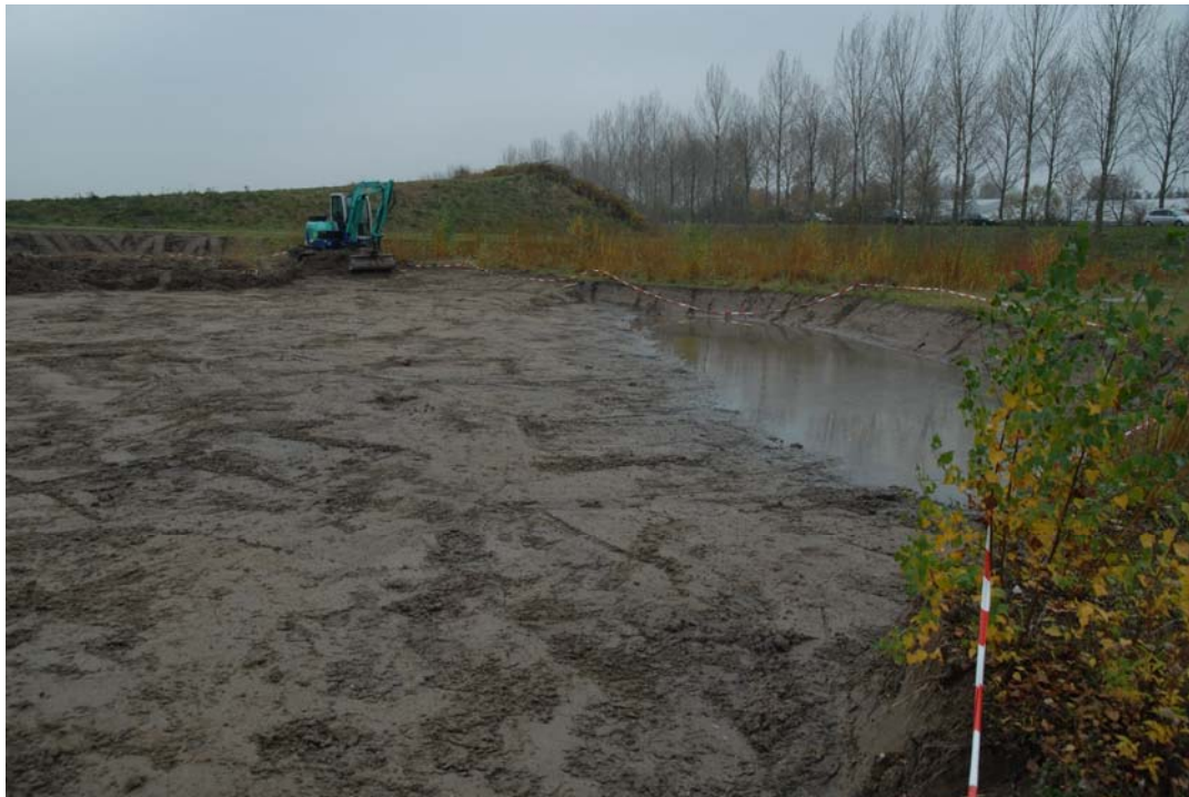
Landschap van de gekantelde percelen (foto boven). In het noordwestelijk deel zijn recent amfibieënpoolen aangelegd. In oktober zijn de graafwerkzaamheden uitgevoerd (foto onder). Foto's 30 oktober 2009, Ben Kruijsen.
